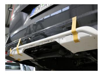
Positionieren Sie nun das Heck-Mittelteil an der Heckschürze und fixieren das Bauteil mit Kreppband.
